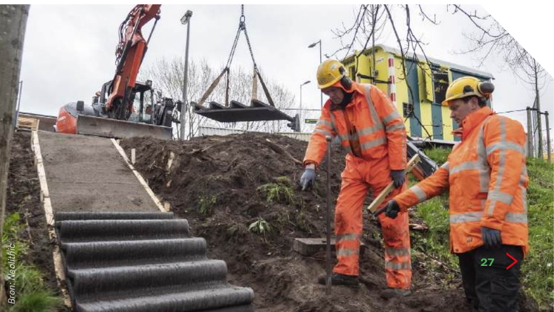
Plaatsing van modulaire en herbruikbare taludtrap elementen
